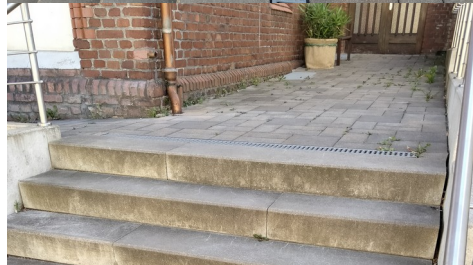
Norbert L. = Sauber halten von der Rollstuhlrampe und dem Eingang.
